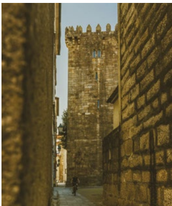
Torre de Menagem · Torre de Menagem
